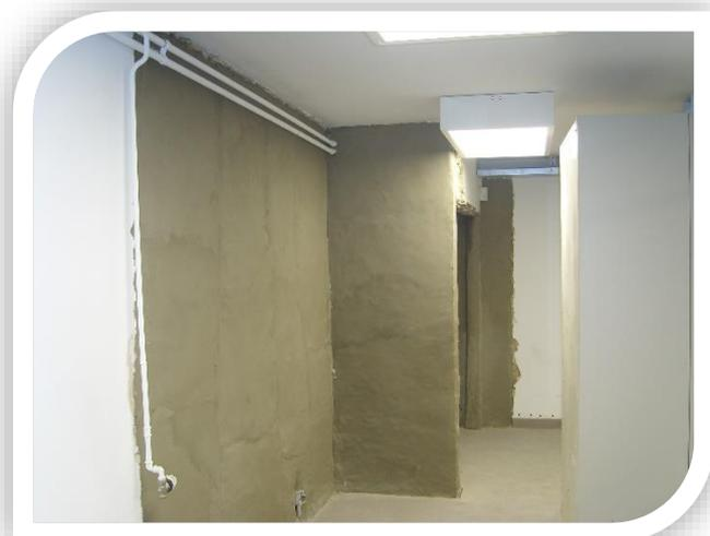
Le B302 est un enduit sec à base de ciment, prêt à l'emploi et avec une très grande étanchéité, convenant pour des applications tant intérieures qu'extérieures. Le B302 est composé de ciment, de sables de quartz sélectionnés et d'additifs de haute qualité. Par simple ajout d'eau, on obtient un enduit étanche avec une haute résistance finale. Les principales caractéristiques du B302 sont: son étanchéité exceptionnelle, sa très bonne ouvrabilité et une adhérence excellente, ...
